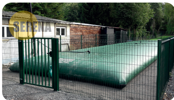
Riserva per la difesa antincendio in superficie
