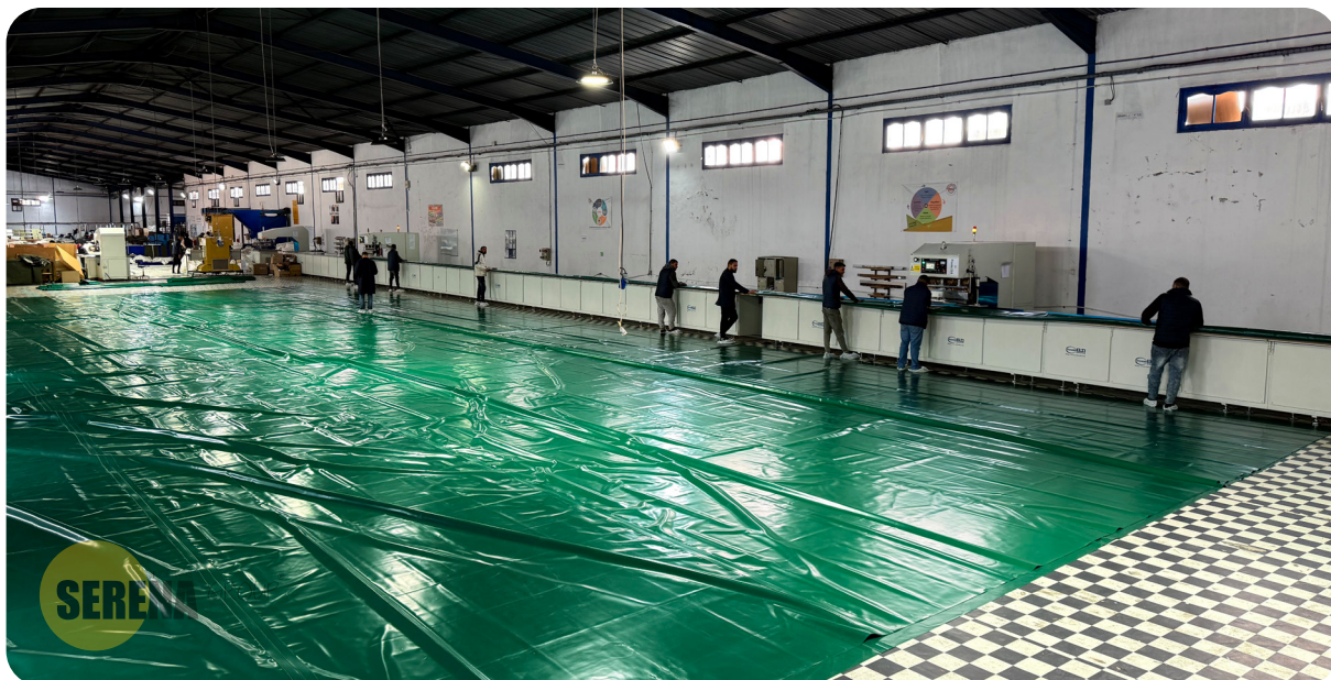
Realizzazione di un serbatoio da 1000 m 3
